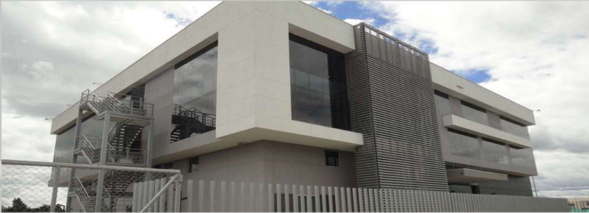
EDIFICIO BITEC- CITEC
